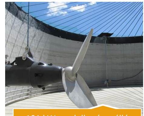
101 kW rendelkezésre álló szabályozható beépített keverő teljesítmény
